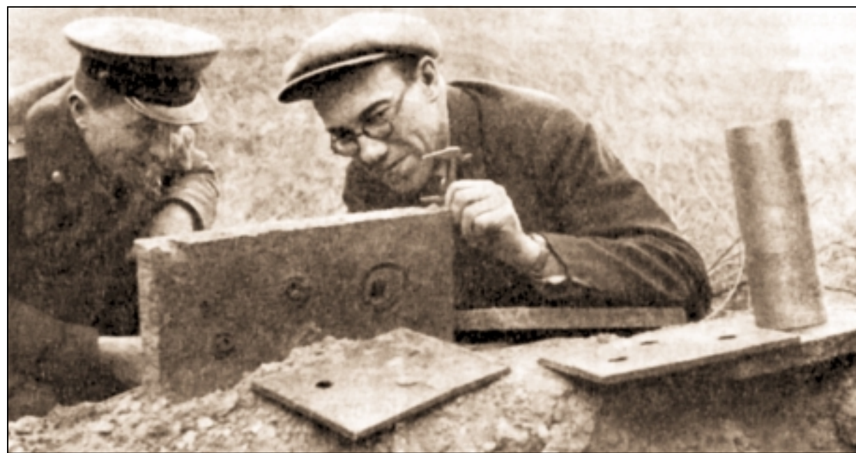
Михаил Алексеевич Лаврентьев изучает пробитие танковой брони кумулятивными снарядами. Украина, 1944 г.
